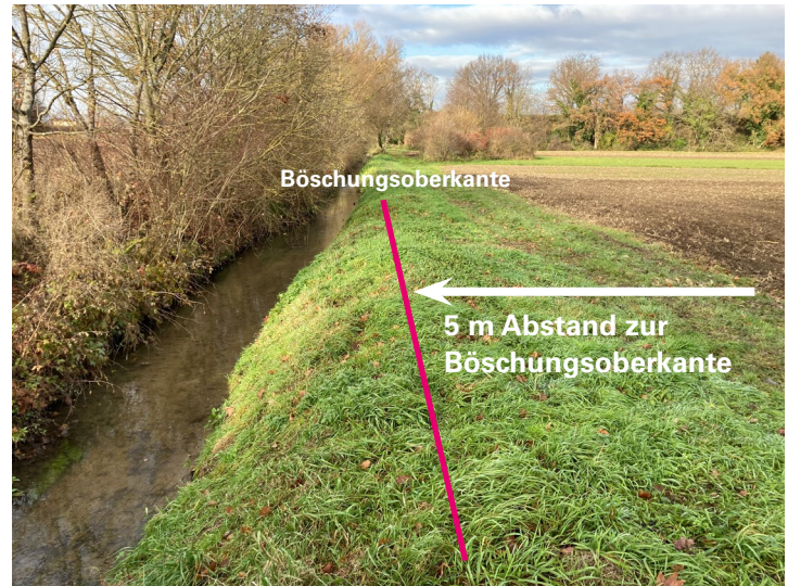
Feststellung des 5 m Bereiches zur Böschungsoberkante
